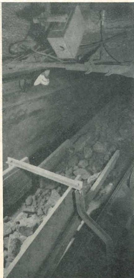
Fig. 2 - Miniera di ferro di Havange: sotto la sua protezione blindata (in alto, in mezzo), la camera televisiva « vede in diretta » il minerale che il frantoio rovescia sul tappeto convogliatore.
