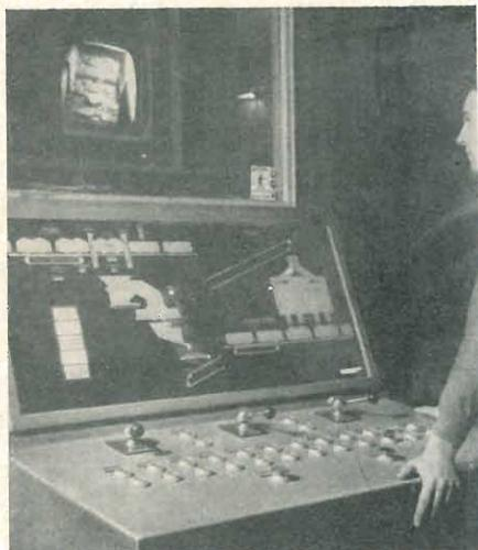
Fig. 1 - Miniera di ferro di Havange: Il sorvegliante controlla su un televisore il trasporto su tappeto convogliatore del minerale che esce da un frantoio.
